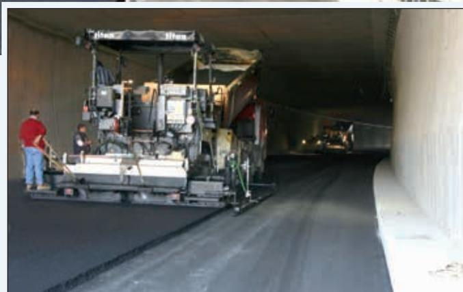
Figura 21 - Un particolare della stesa con sbarra dello strato di binder
