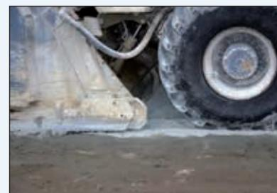
Figura 14 - Un particolare del passaggio del tamburo-fresa con cemento
