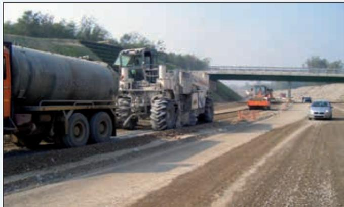
Figura 12 - Il treno di stabilizzazione a cemento con botte acqua
