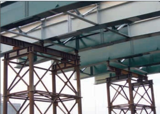
*Figura 10 - Un particolare delle pile provvisorie*
