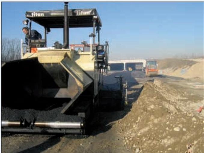
Figura 15 - Un particolare della stesa di mista bitumata
