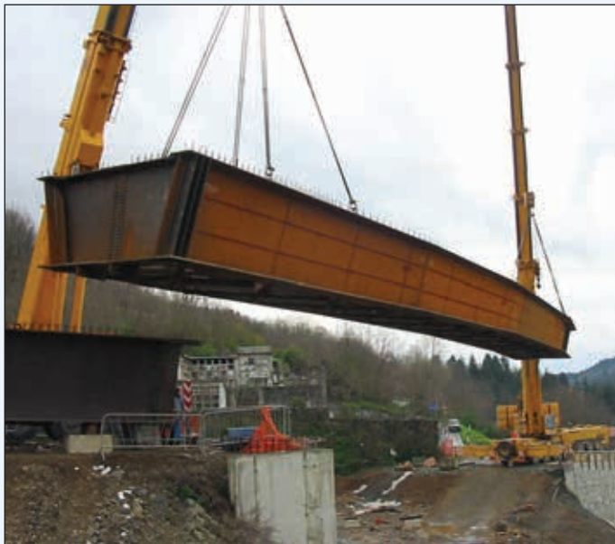
Figura 9 - La fase di montaggio del Lotto 2
