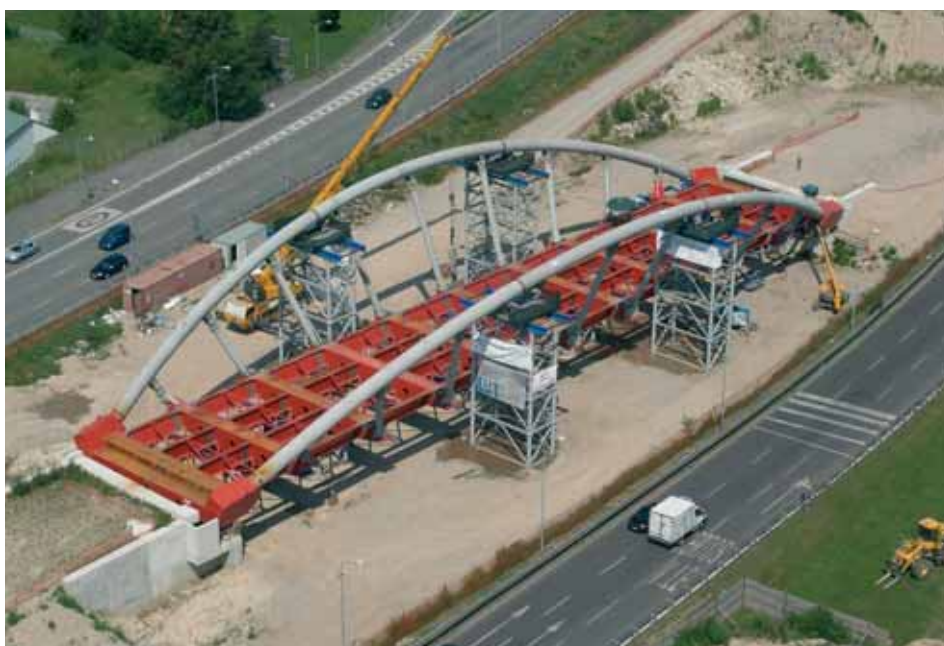
Fig. 24 - Vista aerea del ponte
