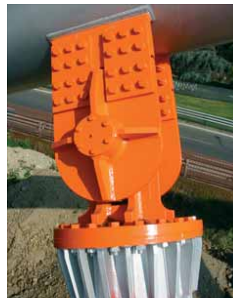
Fig. 3 - Giunto cardanico
