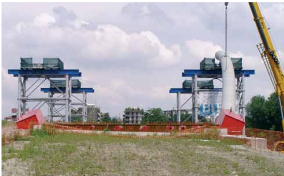
Fig. 16 - Posa primo troncone costituente l'arco
