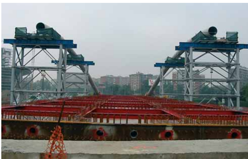
Fig. 17 - Posa quarto troncone costituente l'arco ultimato
