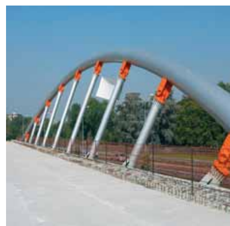
Fig. 19 - Giunti cardanici
