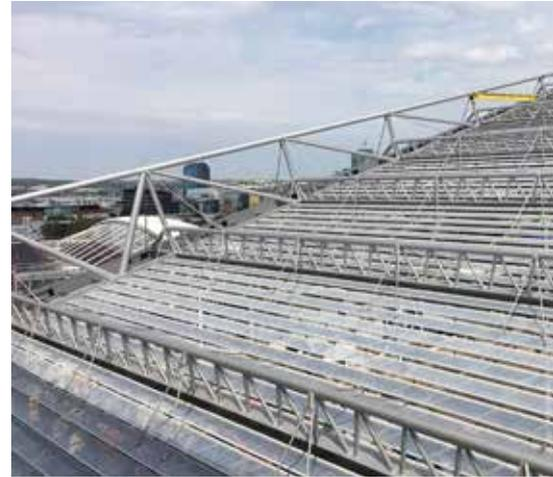
La struttura metallica è appoggiata su due cilindri idraulici nella parte anteriore e su due pile fisse nella parte posteriore, dando vita ad una futuristica pensilina che, nel progetto originale, prevede anche l'applicazione di pannelli luminosi sospesi, offrendo così ai visitatori in ingresso tutti i tipi di messaggi relativi a eventi attuali o futuri.
