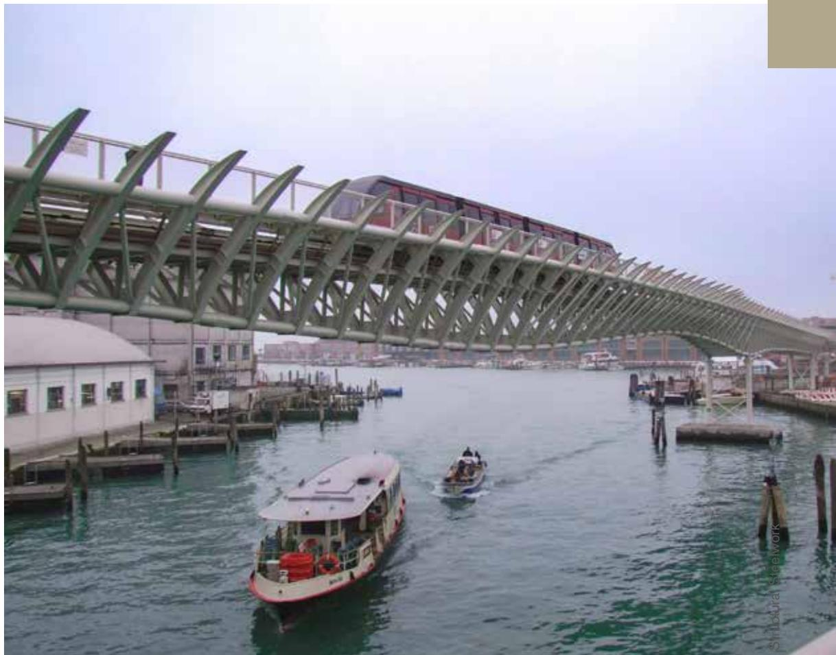
In particolare si tratta di un sistema funicolare su gomma a due convogli che scorrono su una via sopraelevata in acciaio. La caratteristica architettonica principale dell'opera è la sagoma della struttura che, seguendo le variazioni dei momenti statici, disegna il volo del gabbiano che si estende sopra la laguna dando l'idea di un'articolazione spaziale in movimento.
