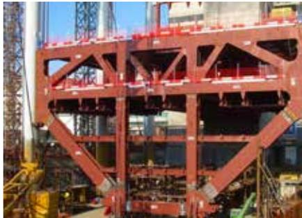
La sede del **nuovo Parlamento Maltese** è composto da due edifici, denominati Office Building e Chamber building, con struttura portante in carpenteria metallica, collegati tra loro in corrispondenza del Primo Piano, del Terzo Piano e della Copertura.
