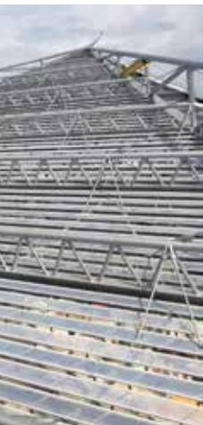
La struttura secondaria è composta da travi tralicciate tipo Warren, parallele alla base del triangolo ad un'intersezione di circa 7,50 m. La lunghezza di queste travi varia da 5 a 40 m, mentre la loro altezza varia da 80 a 180 cm per le travi in prossimità dell'edificio.
