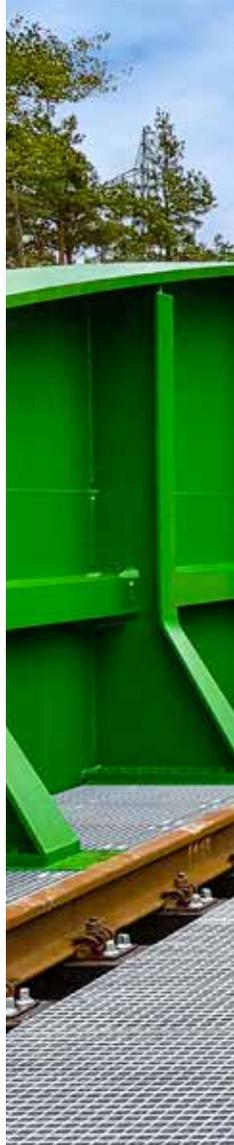
Trattasi di una campata metallica ferroviaria a doppio binario a via inferiore avente interasse tra gli appoggi pari a 30 m. ed una larghezza pari a 9.2 m. Travi a sezione variabile da 2.4 m. a 4.4 m. per un peso complessivo pari a 330 t.
