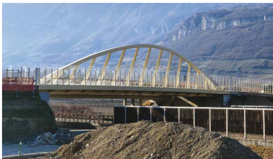
4. Il sovrappasso autostradale della A22 visto da Nord
