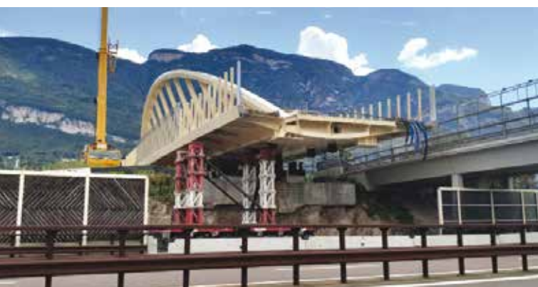
7A e 7B. Il sovrappasso autostradale pronto per la posa in opera (7A) e nella fase di posa in opera in notturna (7B)
