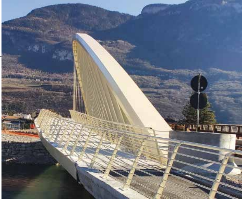
9. La pista pedonale sull'Adige vista da spalla Ovest
