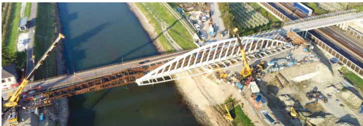
6. La fase di completamento della posa dell'avambecko del ponte fiume Adige
