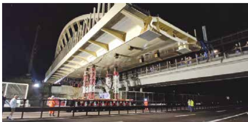
7A e 7B. Il sovrappasso autostradale pronto per la posa in opera (7A) e nella fase di posa in opera in notturna (7B)
